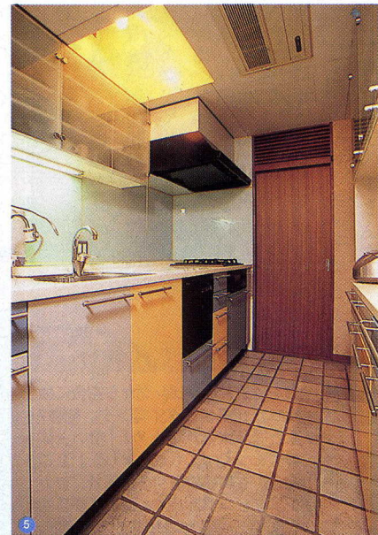
⑤キッチンにはトップライトを設けて明るさを確保。ワークトップは、調理スペースを広くとるために奥行を30cmほど深くした。
